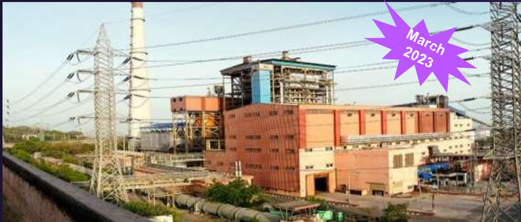
Tata Power Trombay 500 MW
